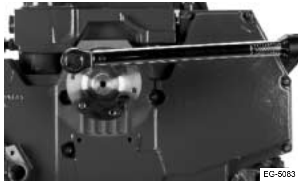
Figura 8.36 Instalación del núcleo impulsor del ventilador
