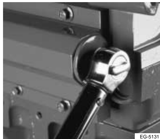
Figura 12.4 Instalación del tapón de extremo
