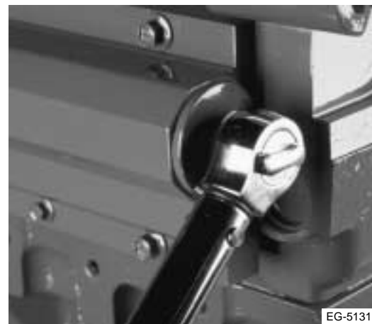
Figura 4.11 Instalación del tapón de extremo
