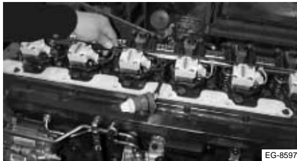
Figura 4.7 Retiro del haz de cables
