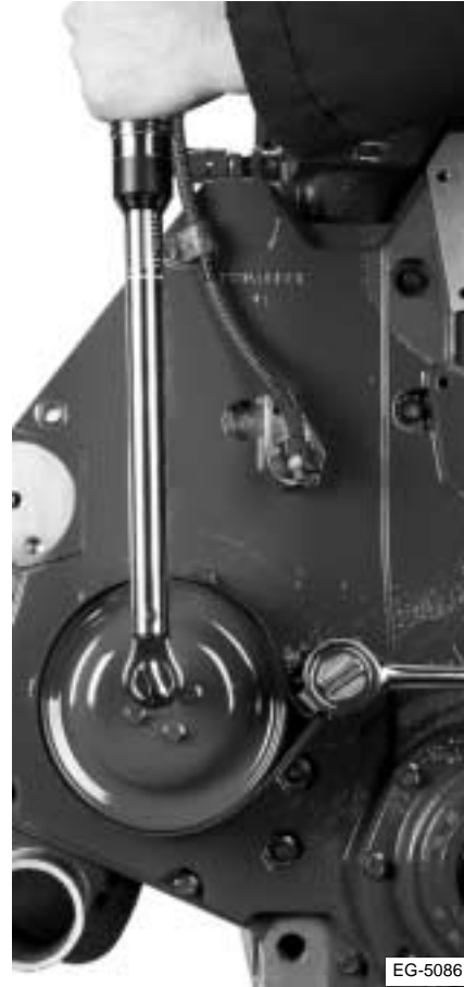
Figura 10.6 Instalación de la polea de la bomba de agua
